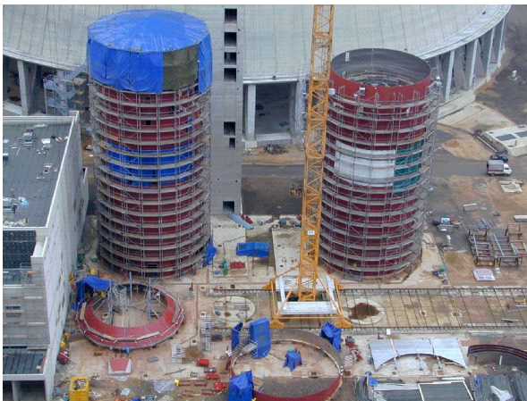
Bau von REA-Absorbern aus walzplattierten Blechen mit alloy 59
